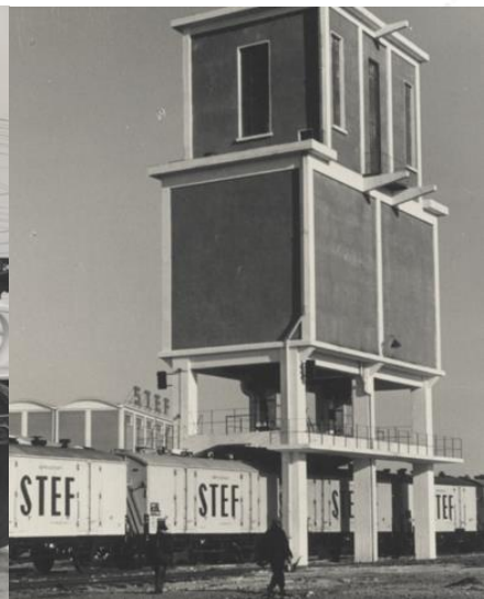
LES TOURS DE GLAÇAGE
